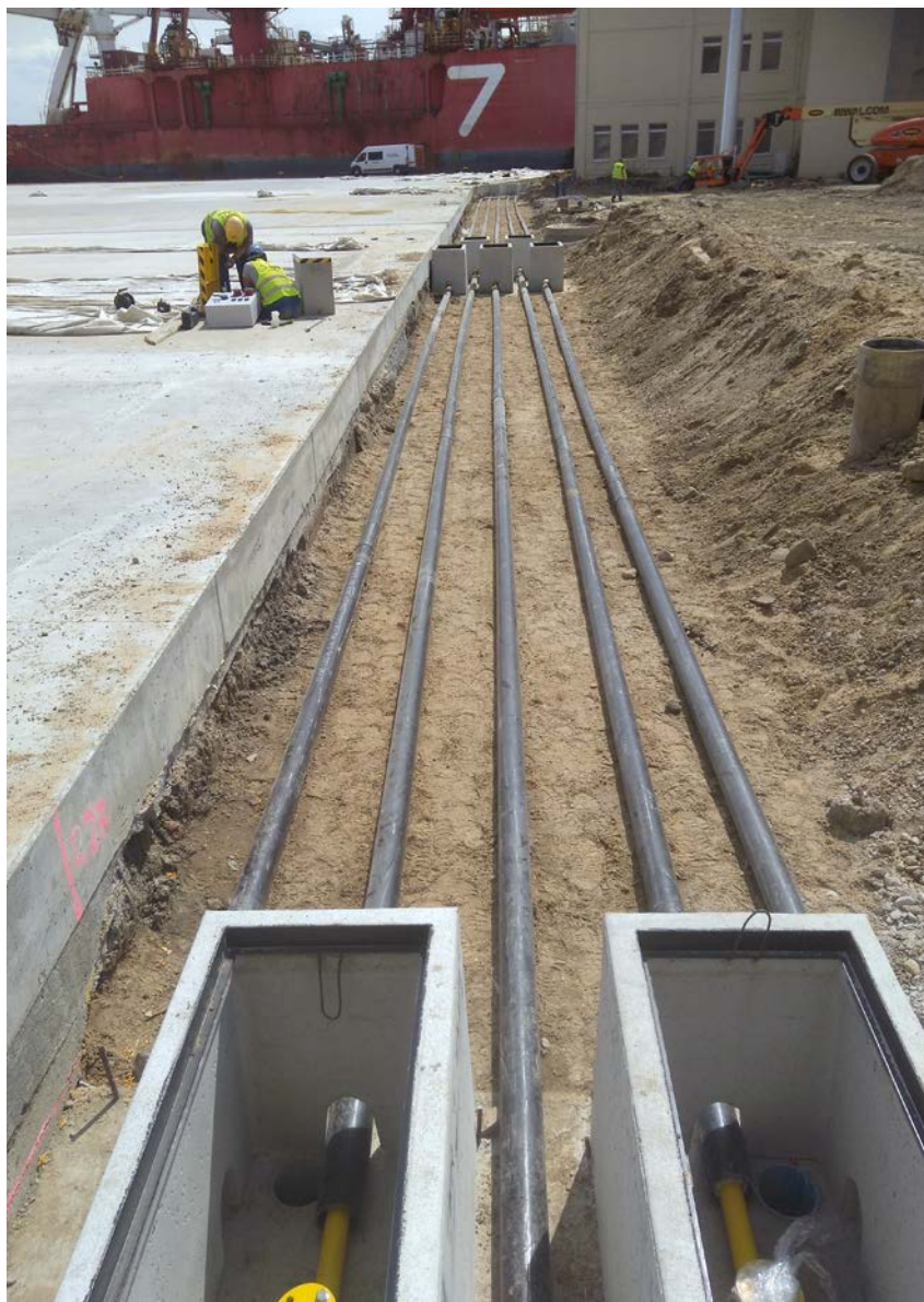
Budowa gazociągów technologicznych na terenie Stoczni Gdańskiej - Wyspa Ostrów. Fot. arch. Elmal
