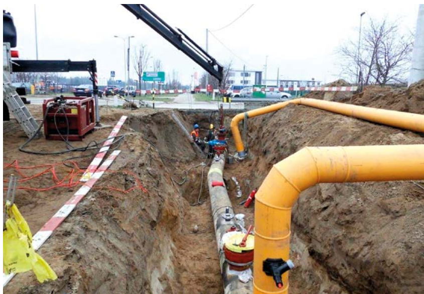
Budowa Pomorskiej Kolei Metropolitalnej - przebudowa gazoc. zasilającego Gdańsk bez zatrzymania przepływu. Widać bypass dn250PE. Gdańsk ul. Nowatorów. Fot. arch. Suchocki
