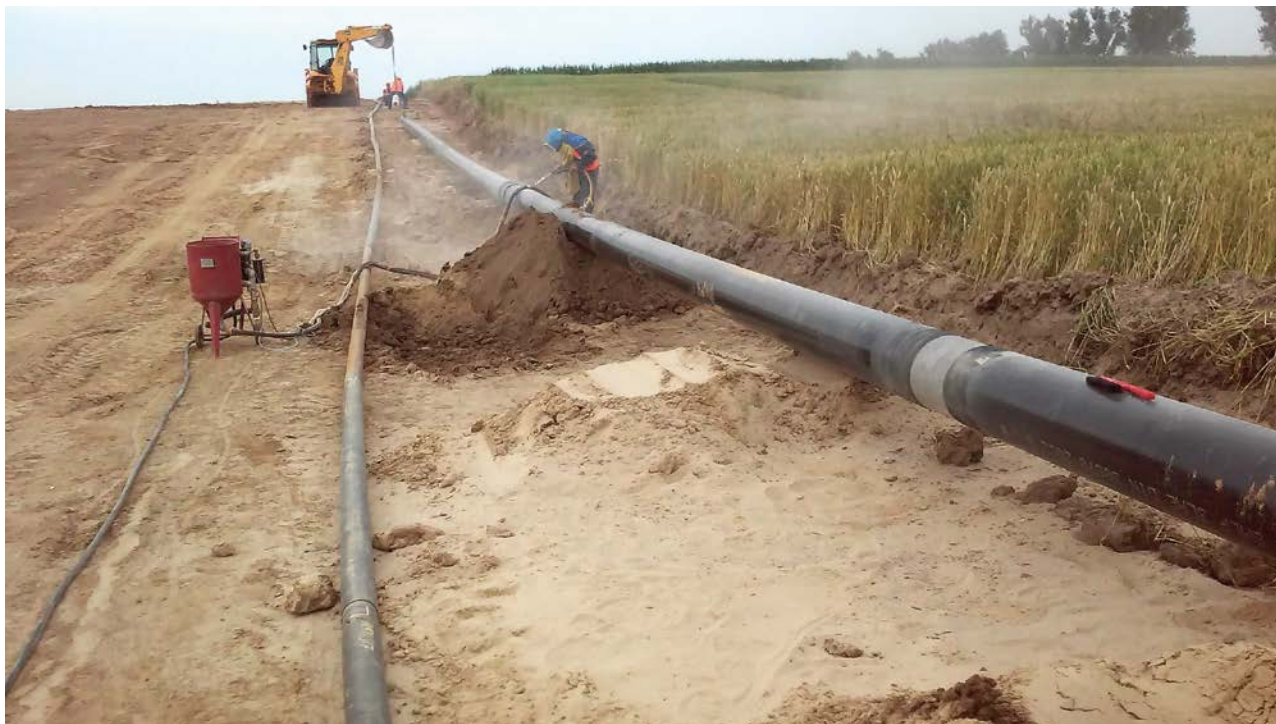
Przebudowa gazoc. wc dn150 - na zadaniu Budowa drogi ekspresowej S-5 Szubin-Jaroszewo. Fot. arch. Elmal
