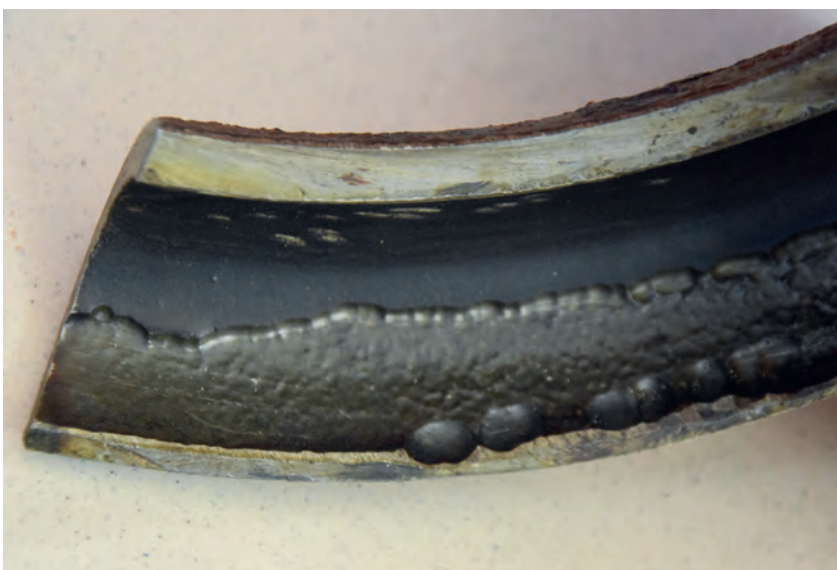
Fot. 2. Fragment kolana z widoczną korozją wżerową i ambrozją. Arch. INiG - PIB
