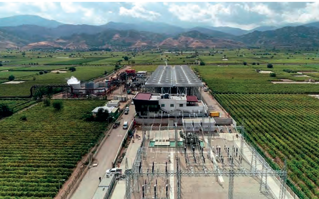
Elektrownia geotermalna firmy Maspo Enerji w Alasehir (Manisa) nieopodal Izmiru (źródło: MASPO Enerji)
