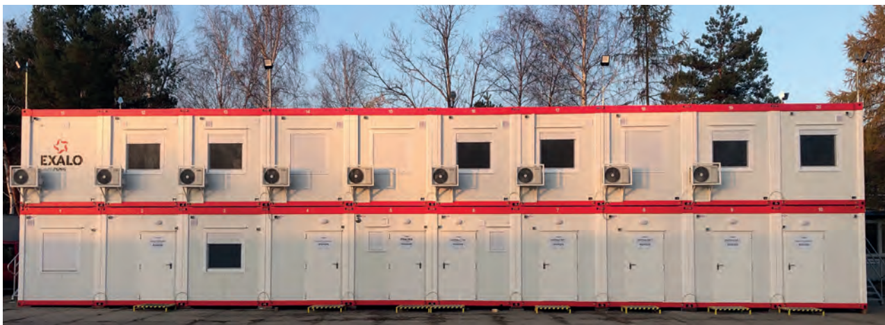
Kompleks socjalno-biurowy (źródło: Exalo Drilling S.A.)
