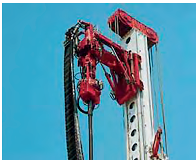
Top Drive w osi otworu pomocniczego (źródło: Drillmec SPA)
